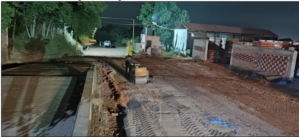
Registro fotográfico Rellenos y compactación.
